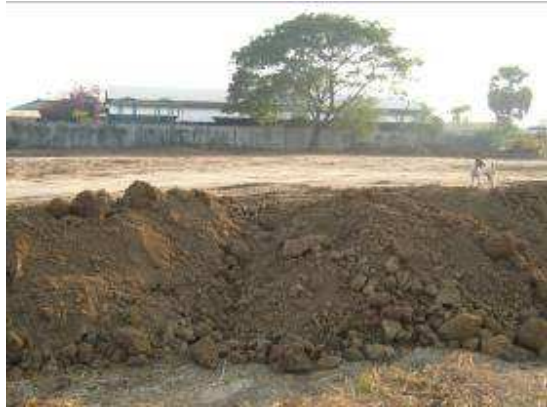
Het bouwterrein wordt 1 meter opgehoogd.
