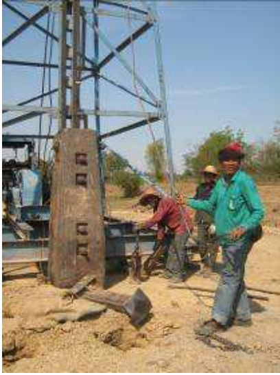
Ruim 2 weken lang worden er non-stop heipalen de grond ingeslagen.
