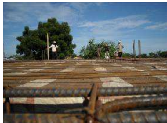
De cement vloer kan eerdaags gestort worden.
