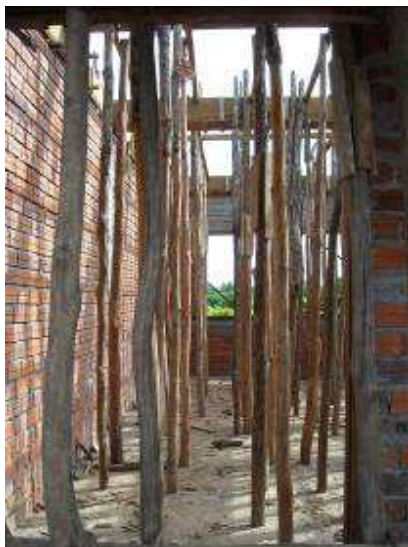
Palen ter ondersteuning van de vloer (1ste verdieping).
