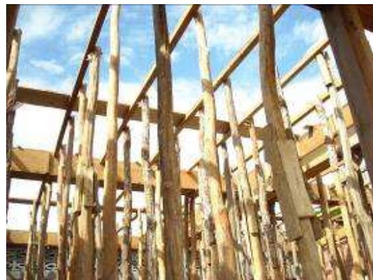
Palen ter ondersteuning van de vloer (1ste verdieping).
