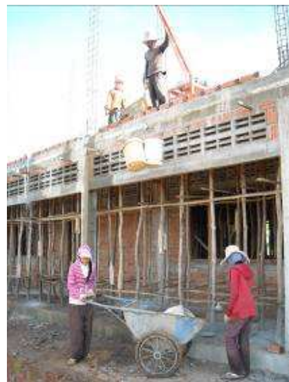
Fase 2: zand en bakstenen worden behoedzaam naar boven getakeld.
