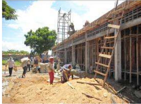
De cement vloer (1ste verdieping) wordt gestort.
