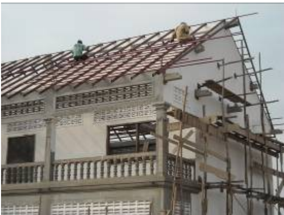
Lassen dakraamwerk.
