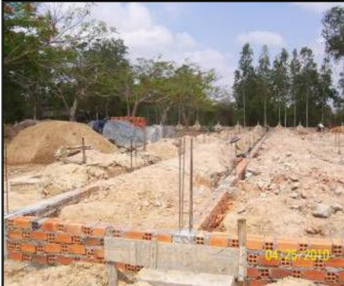
In april 2010 werd begonnen met de bouw van de nieuwe school in Chencheang.
