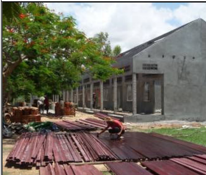
In juni bezochten wij tijdens een werkbezoek de school. De werkzaamheden waren toen in volle gang en de bouw was al ver gevorderd.
